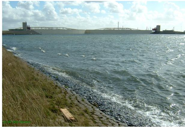
Abb. 4.4.4: Das Maeslant-Sturmflutsperrwerk, Tore geschlossen (Bildquelle: Foto: Quistnix <https://commons.wikimedia.org/w/index.php?curid=353716>, CC BY 2.5)
